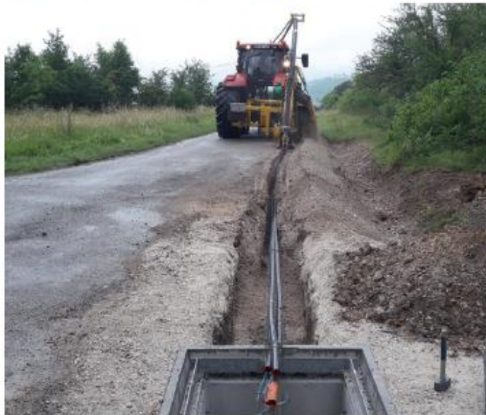
Déploiement fibre optique sur le secteur de Saint-Nazaire-de-Valentane pour la montée en débit ADSL (mai 2017).
